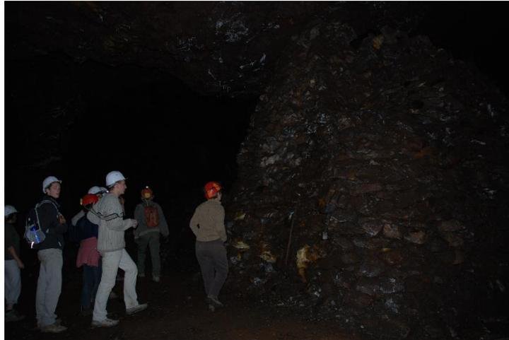
**fig. 8** Mur de pierre soutenant le toit du couloir
